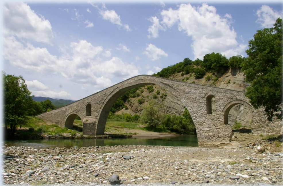
Γεφύρι Αζίζ Αγά (1727), Τρίκωμο Γρεβενών
